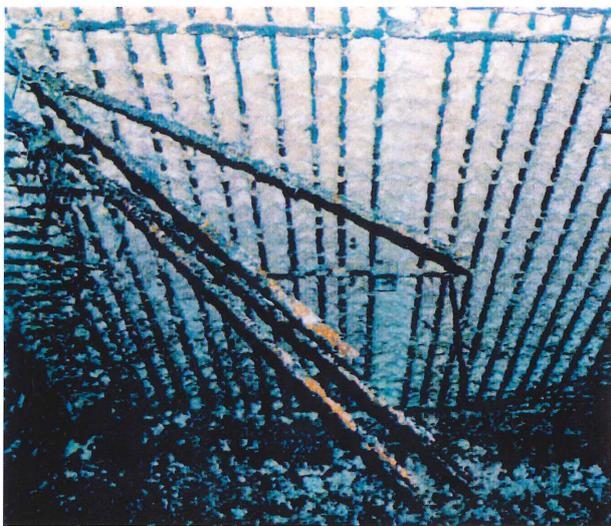
■下水道施設コンクリートの劣化
